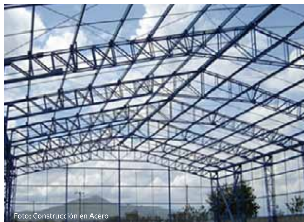
Foto: Construcción en Acero
